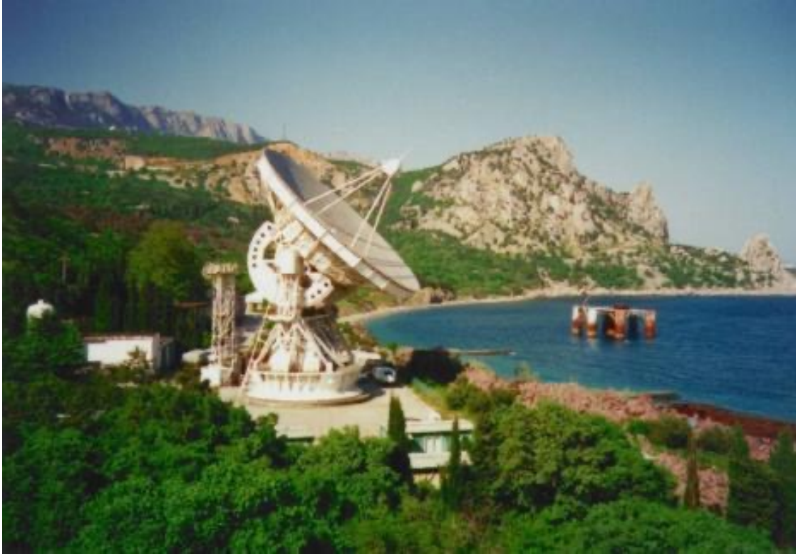
РТ-22 КрАО РАН, построен в 1966 г. СКО \sim 0.25 мм, КИП (3мм) \sim 20\%
