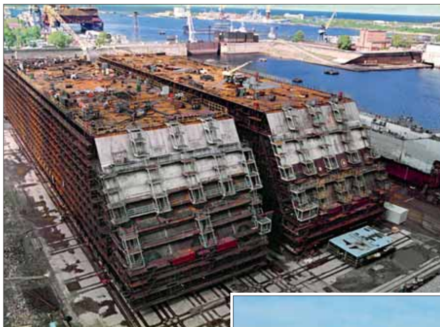
Стыковка суперблоков опорного основания «Приразломной».
