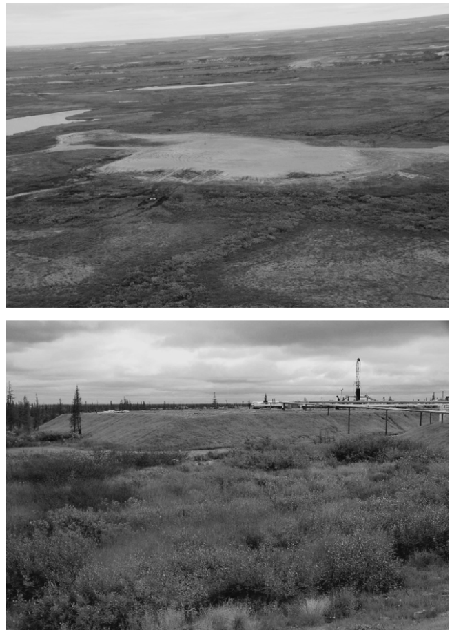
Рис. 2. Буровая площадка до (вверху) и после (внизу) рекультивации почв
