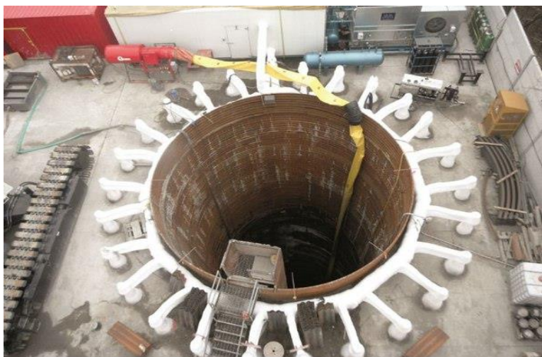
Рис. 3. Система оптоволоконного термометрического контроля состояния ледопородного ограждения при строительстве шахтных стволов
