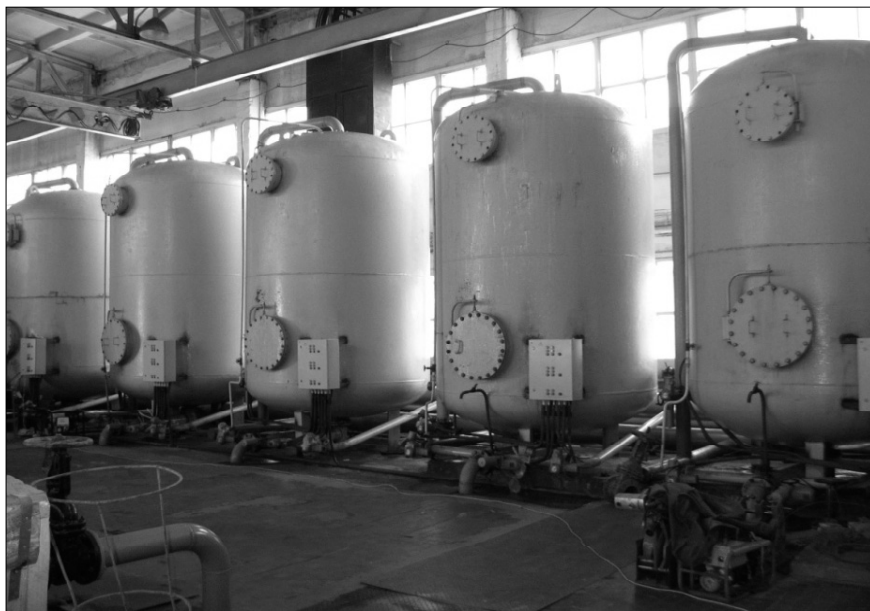
Рис. 4. Установка по реализации и промышленной проверке реагентно-каталитического метода очистки питьевой воды
